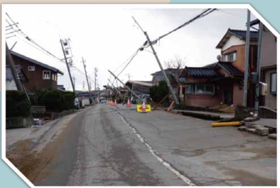
※液状化による道路・ライフラインの被害（能登半島地震）
